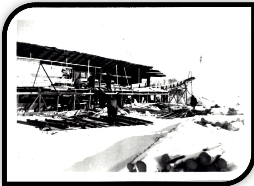
Moulin du Syndicat à Val-Paradis. Cette année-là, la couverture a cédé sous le poids de la neige.
